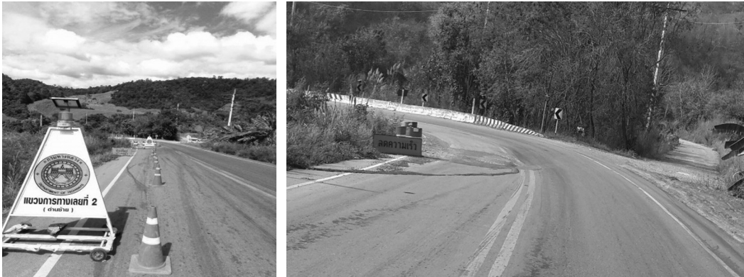
ภาพถนนทรุด มีการตั้งป้ายเตือน ถนนที่ปรับปรุงแล้ว แต่ยังคงป้ายเตือนไว้
