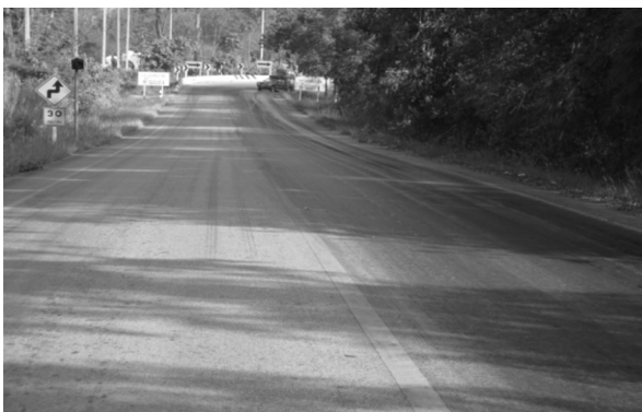
ภาพถนนเดิมที่มีคราบน้ำยางเปื้อนผิวถนนภาพพื้นผิวถนนที่มีการลาดใหม่
